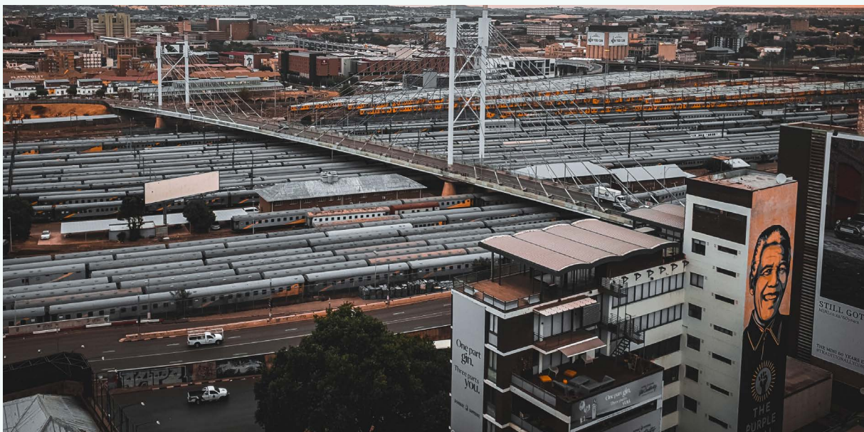
FOTO: Trenes pasando bajo el puente Mandela en Johannesburgo (Sudáfrica) de Tembinkosi Sikupela | FUENTE: Unsplash
